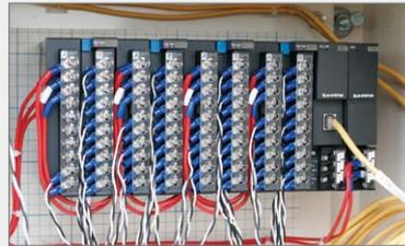
将远程I/O安装在电力配电盘内部闲置空间，可通过场局域网有效地采集数据。
